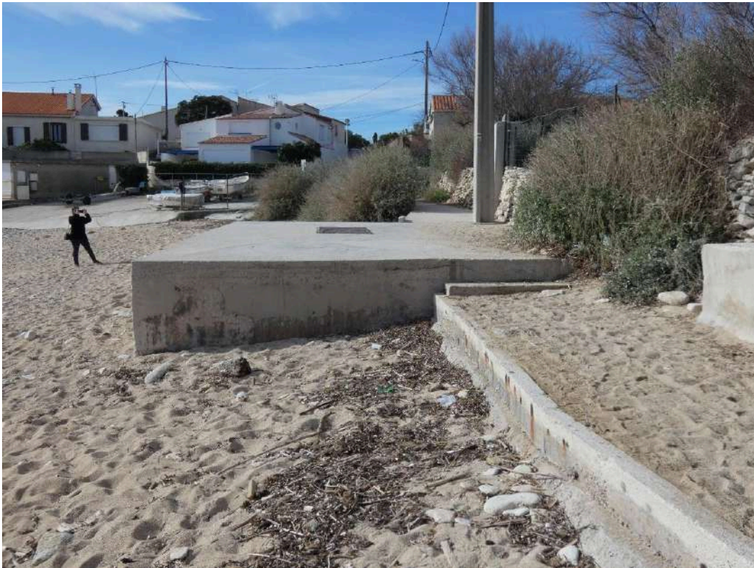
Fig. 3. Le caisson d'atterrage des câbles sous-marins, anse de la Couronne Vieille, Martigues. Crédit: PMCB.
