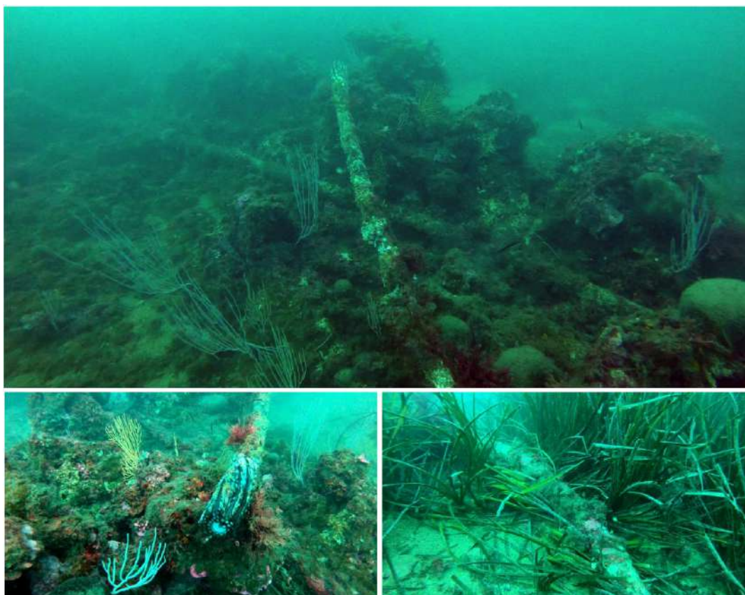
Fig. 15. Câble sous-marin Amitié, déplacé par la houle pendant le chantier.
