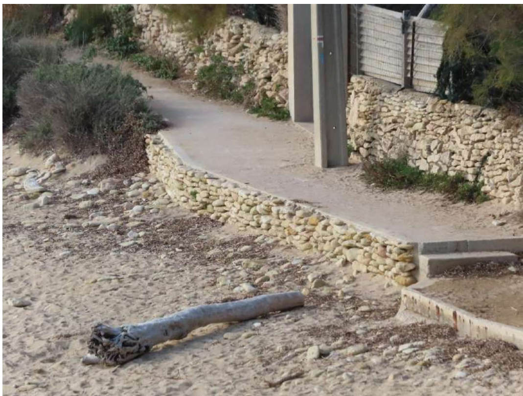
Fig. 7. Le caisson d'atterrage des câbles sous-marins, après réhabilitation, avec des pierres collées en façade, anse de la Couronne Vieille, Martigues.
