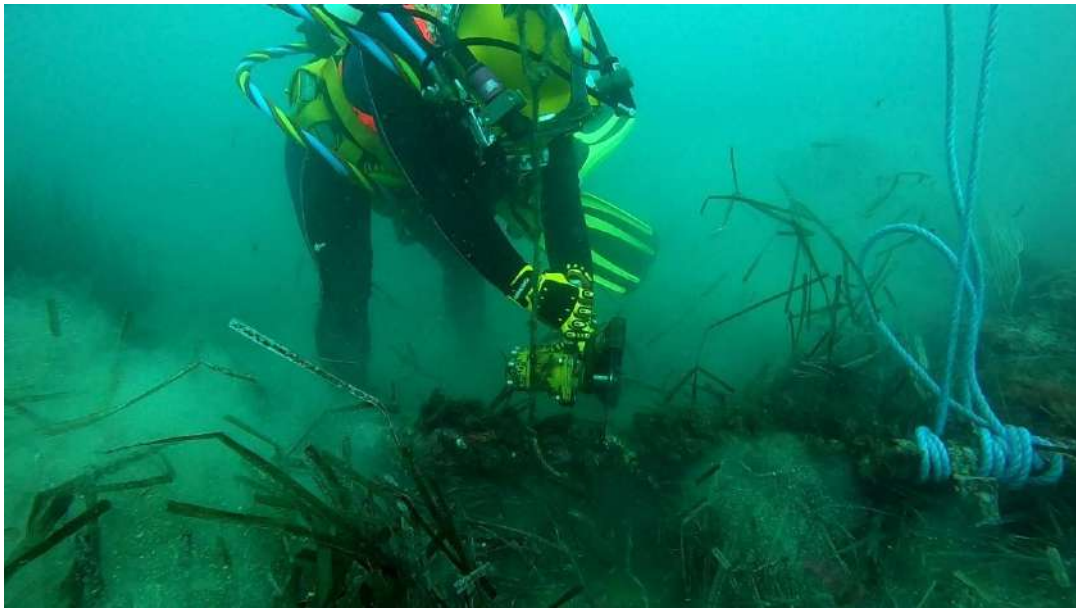
Figure 10. Scaphandrier manipulant une scie hydraulique. Crédit : PMCB
