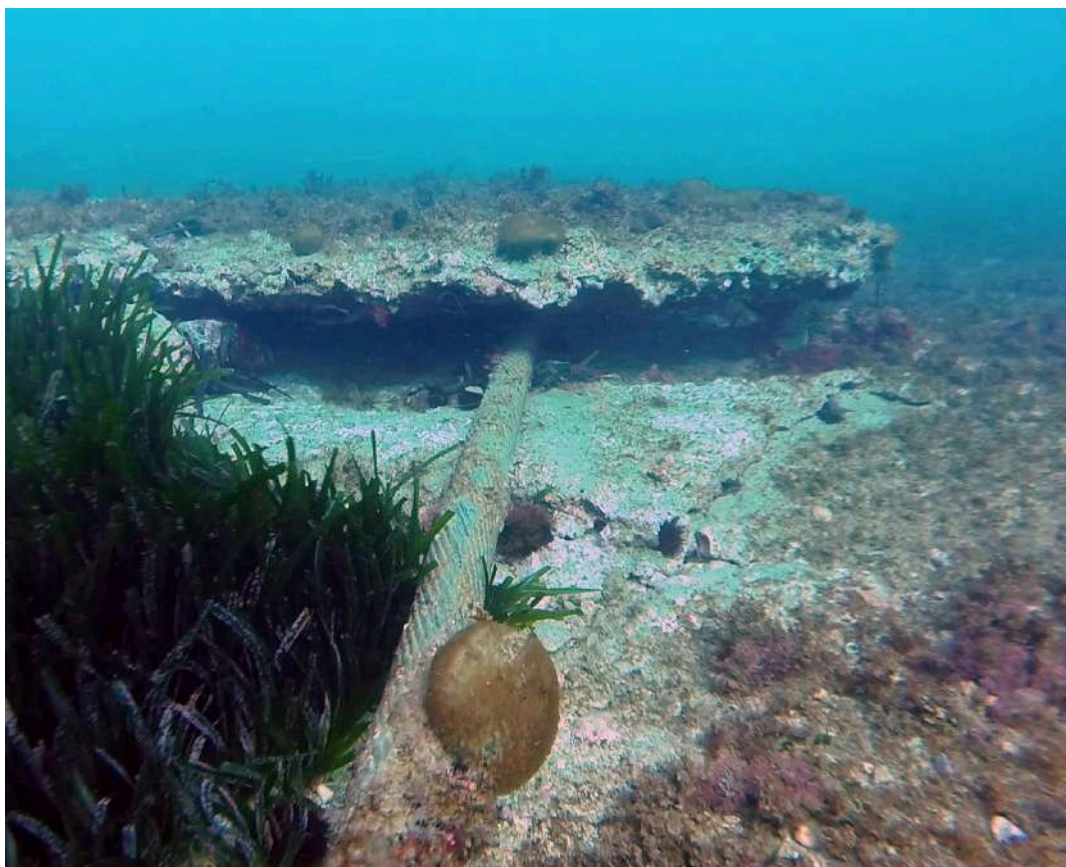
Figure 11. Câble passant sous un rocher. Crédit: PMCB
