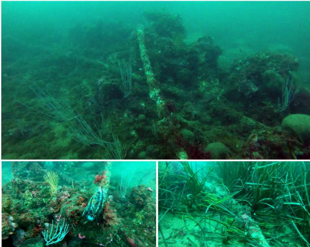
Fig. 15. Câble sous-marin Amitié, déplacé par la houle pendant le chantier.
